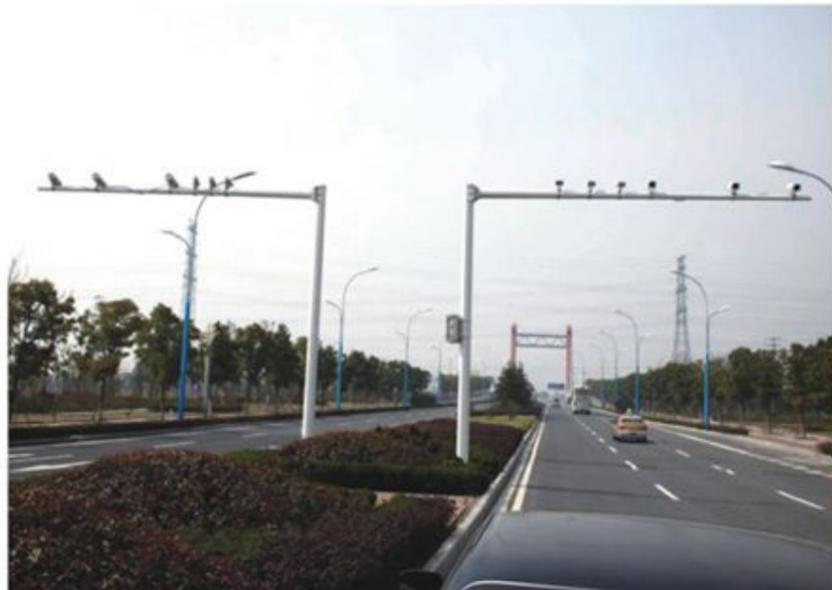
سامانه کنترل سرعت متوسط خودکار ARG-ANPR با تشخیص و ثبت شماره پلاک خودرو در ورودی و خروجی محل‌های نصب سیستم قادر است زمان عبور در مقطع مشخص از راه را اندازه گیری و از طریق سرعت متوسط عبور وسایل نقلیه در آن مقطع را ثبت نماید. شماره پلاک خودروها در این سیستم به صورت خودکار استخراج می شود و از این طریق می توان ضمن شمارش تعداد وسایل نقلیه عبوری و انواع آن، خودروهای تحت تعقیب را نیز شناسایی نمود.
